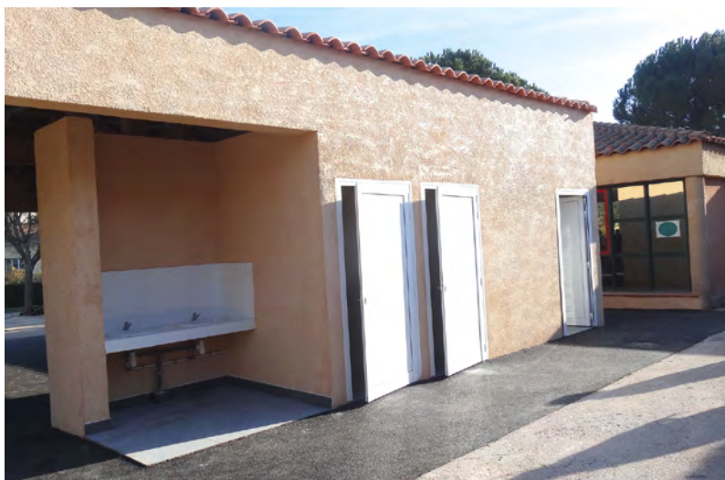
Sanitaires à l'arrière du préau
