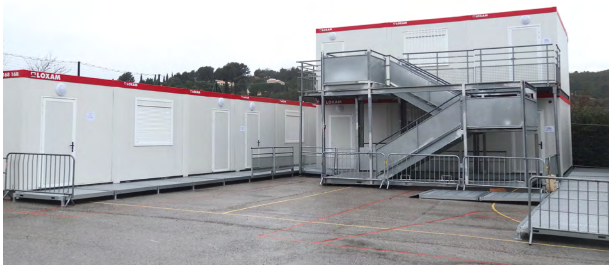
6 classes sont logées dans des bâtiments modulaires de 54 m 2 chacune
