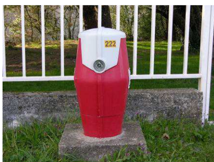
Exemples de numérotation de poteaux incendie
