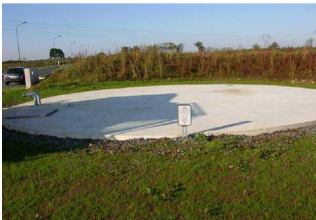
Réserve d'eau enterrée
