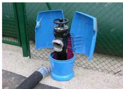
Poteau d'aspiration de 100 mm
